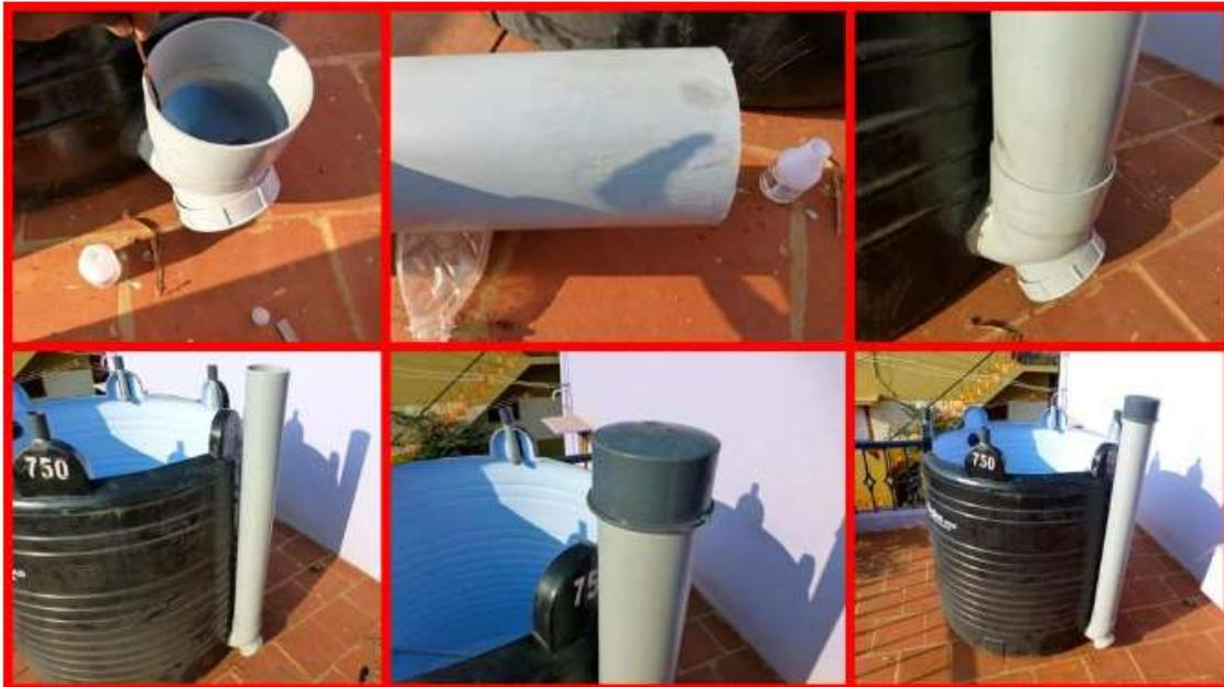
**Anexo 15:** Preparación de la tubería de entrada de desechos.
