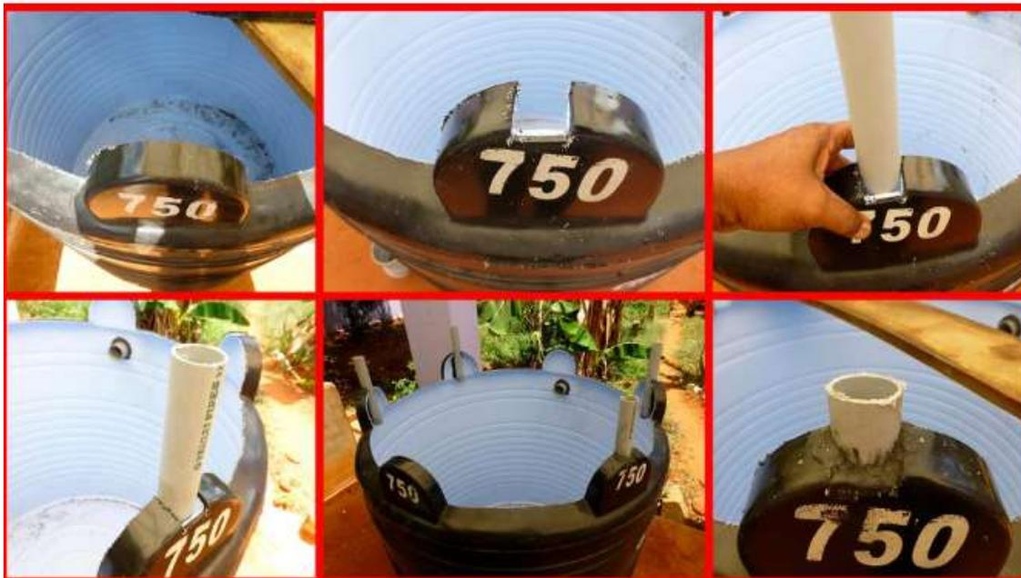
**Anexo 13:** Proporcionar soporte de guía en el tanque colector de gas.
