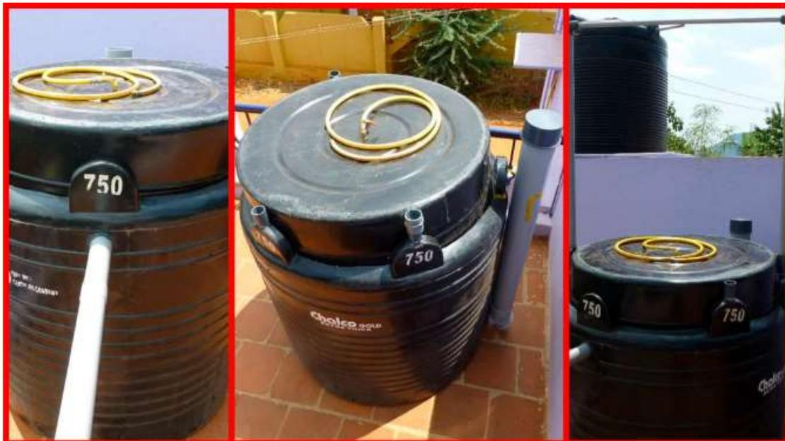
**Anexo 16:** Coloque el tanque colector de gas y termine su biodigestor casero.
