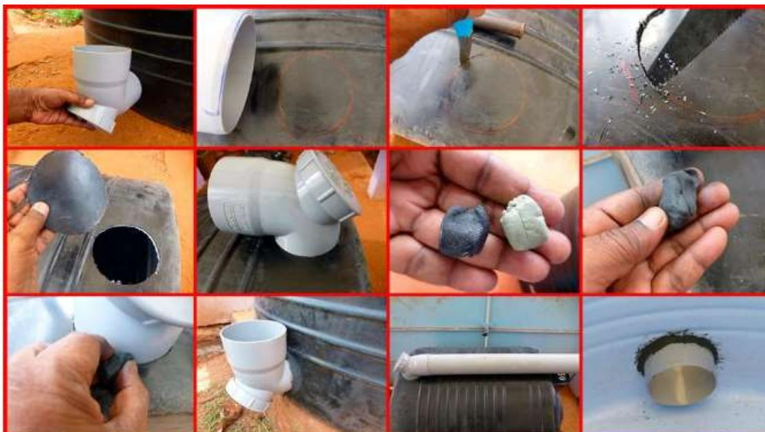
**Anexo 11:** Colocar la tubería de entrada al tanque digestor
