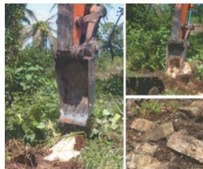
Ilustración 18 Modificaciones de la pala de la excavadora para la destrucción de estípites de palmas.
