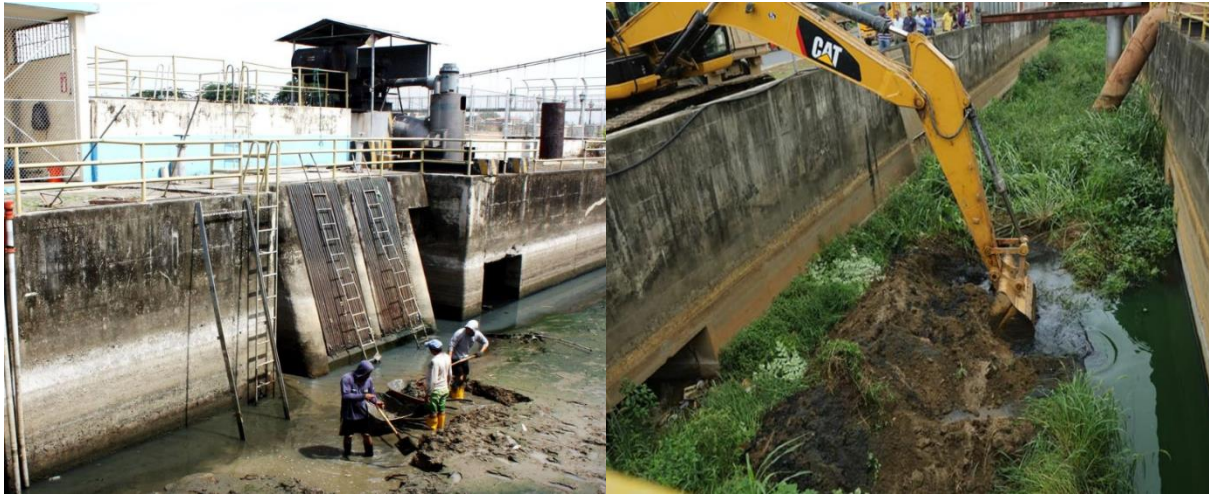
Figura 4. Mantenimiento a las estaciones de agua lluvia 1 y 2 Fuente: (EMSABA EP, 2018)
