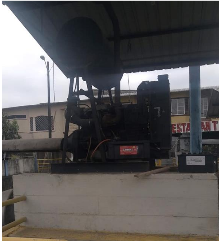
Figura 7. Bomba mecánica de recolección de agua lluvia Fuente: (EMSABA EP, 2018)
