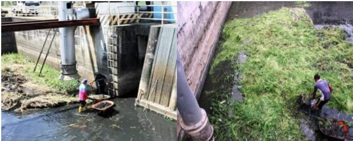
Figura 5. Mantenimiento a las estaciones de agua lluvia 5 y 6 Fuente: (EMSABA EP, 2018)
