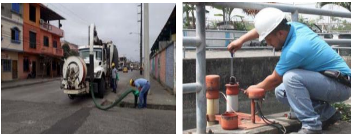
Figura 3. Mantenimiento a los sistemas de drenaje pluvial de Babahoyo Fuente: (EMSABA EP, 2018)
