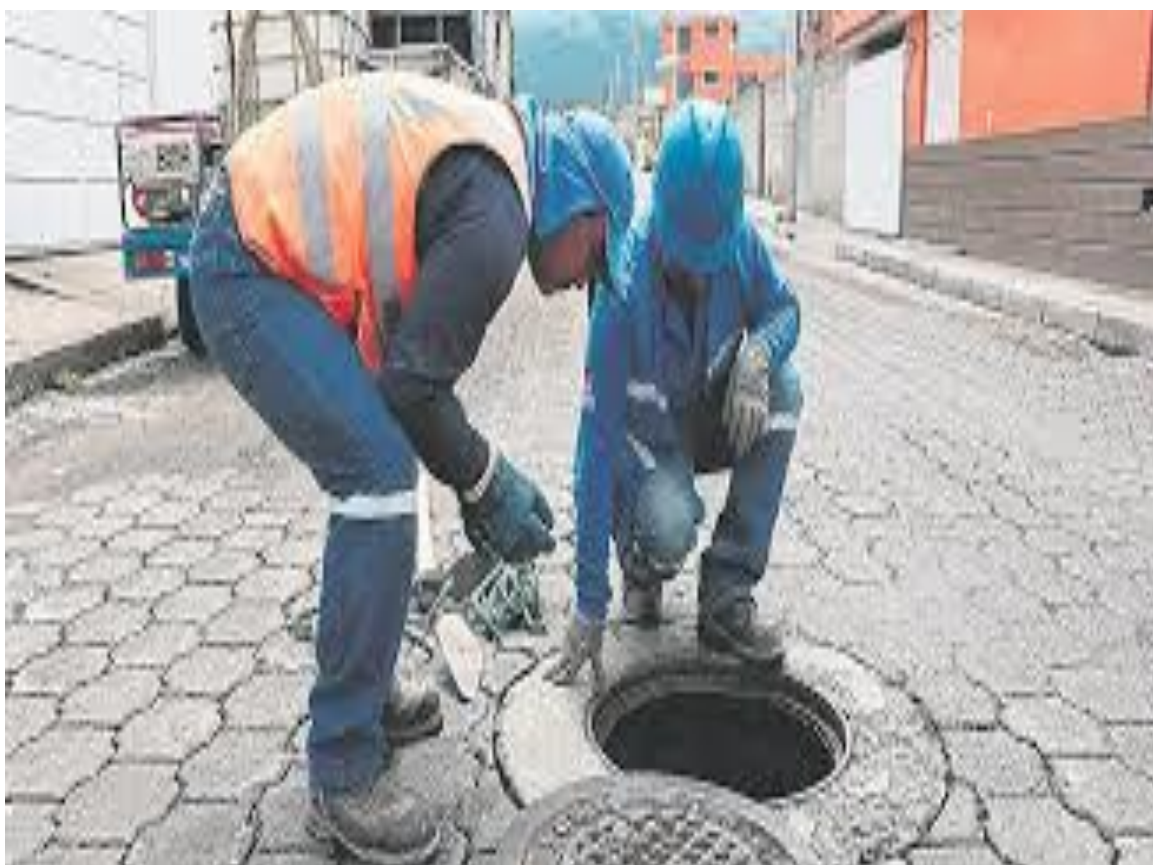
Foto 2: Descontaminación de alcantarillas
