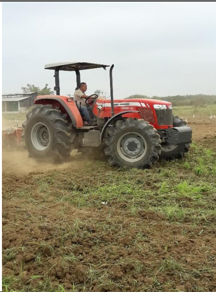
Preparación del terreno
