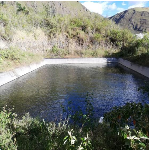
Foto 7.- Reservorio de almacenamiento.
