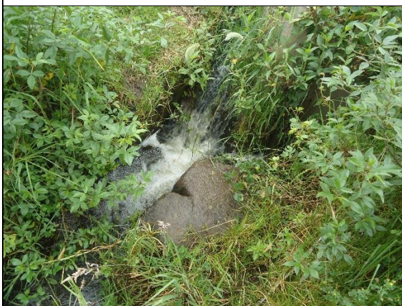
Imagen 5 Repartidor desde la acequia principal a secundaria
