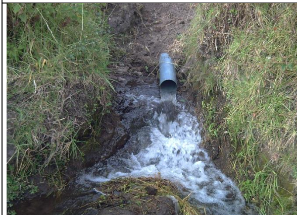
Imagen 3 Entrega de tubería longitud 1300 m
