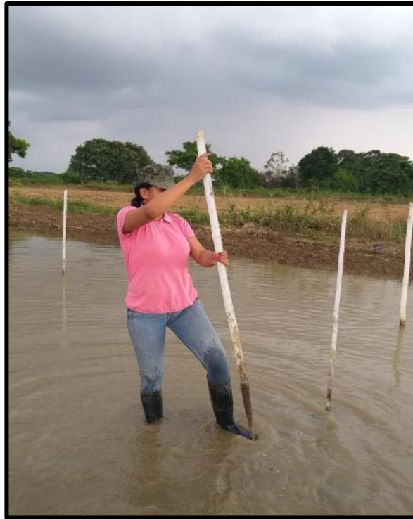
Fig. 1. Estaquillamiento del terreno
