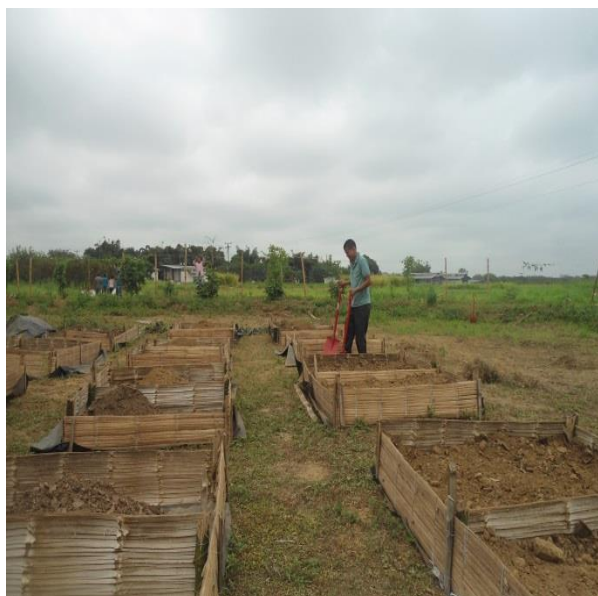
Imagen 3. Construcción de cajoneras
