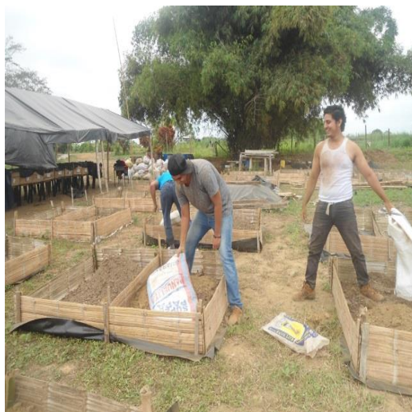
Imagen 4. Llenado de cajoneras con suelo agrícola.
