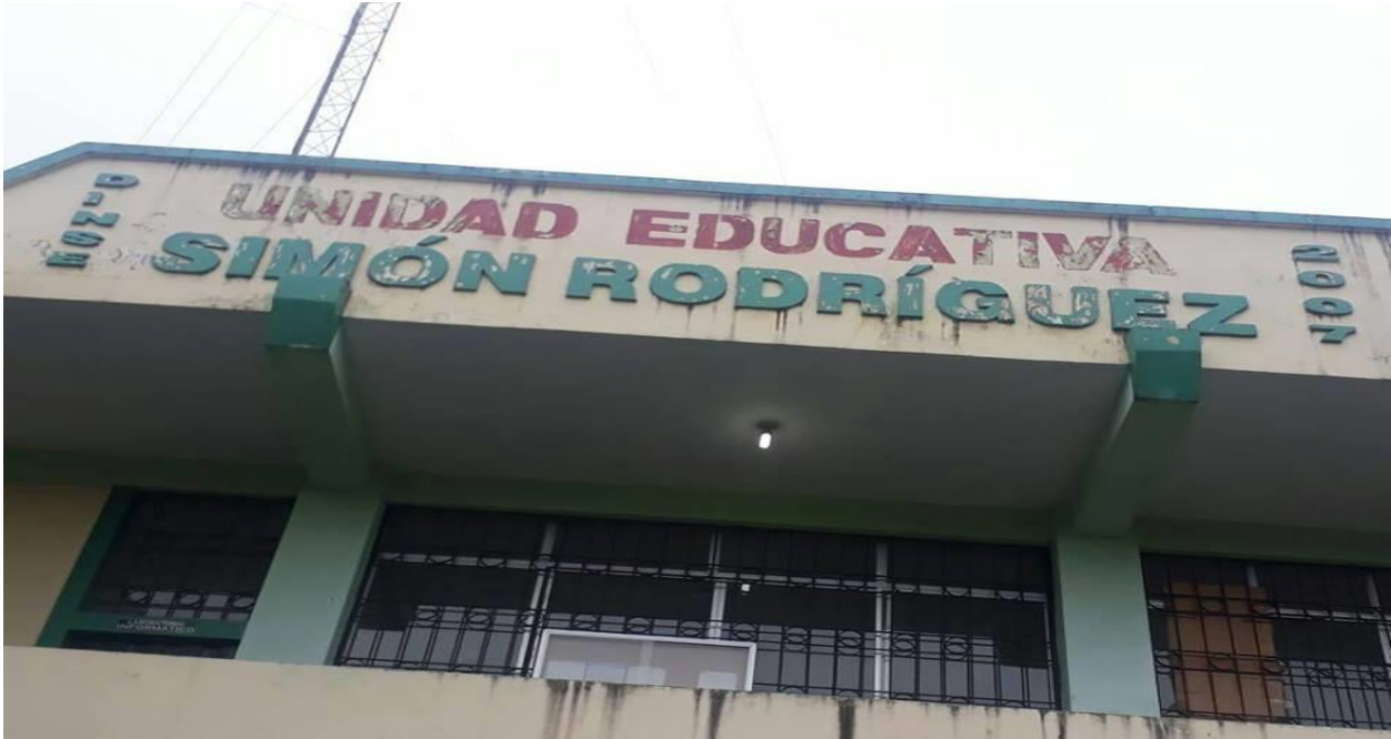
Foto 2. Instalaciones de la Unidad Educativa Simón Rodríguez
