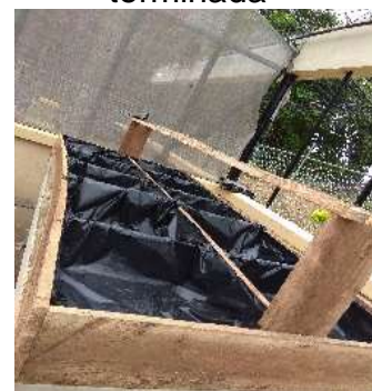
Platabanda lista para la colocación de tierra
