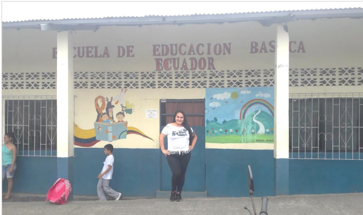
Observación y exploración inicial de la situación física y actual de la Unidad Educativa “Ecuador”
