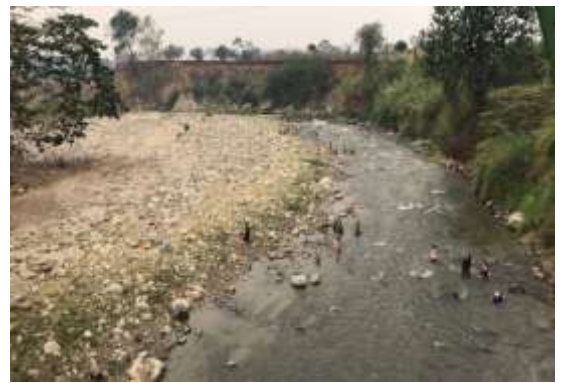
FIGURA N°9 parte inferior del puente por donde continua el caudal.
