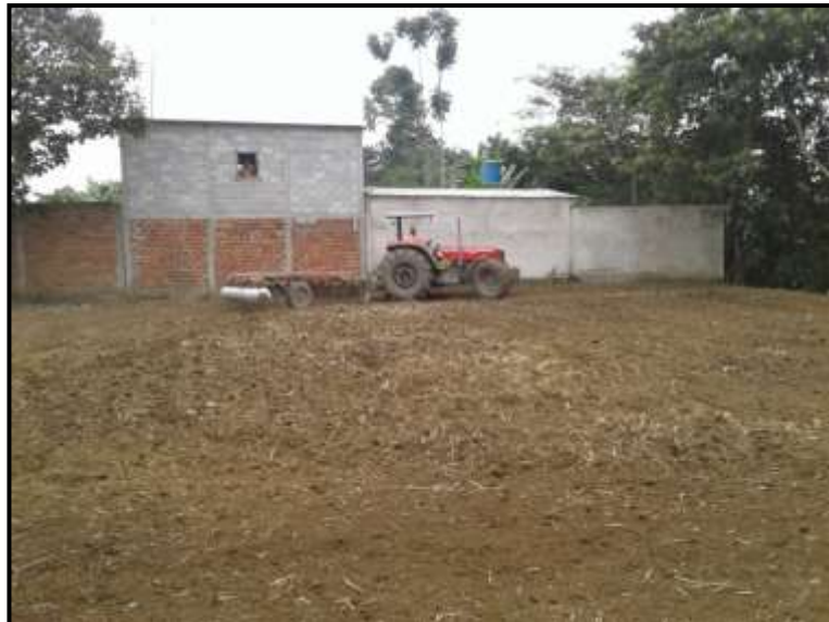
Fig 2. Preparación del terreno.
