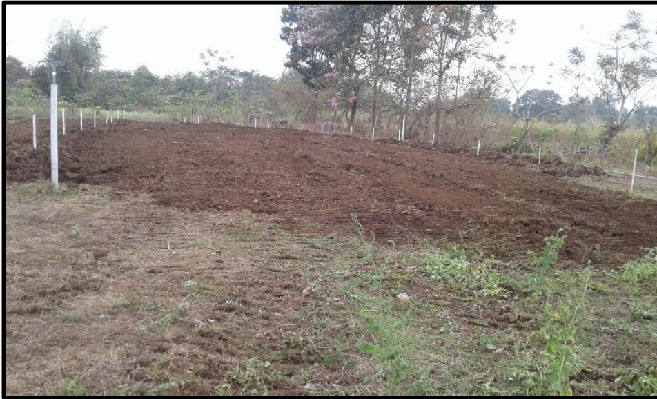
Fig. 1. Preparación del terreno
