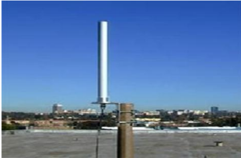
Imagen No 6 Antena omnidireccional tipo monopolo. Fuente: Miguel Angel Rocha Gámez
