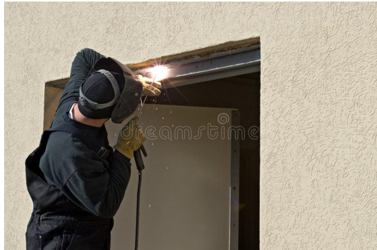
Figura 5.- Soldadura de puerta.
