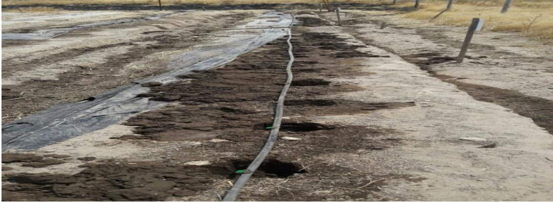
Foto 4. Colocación de riego por goteo
