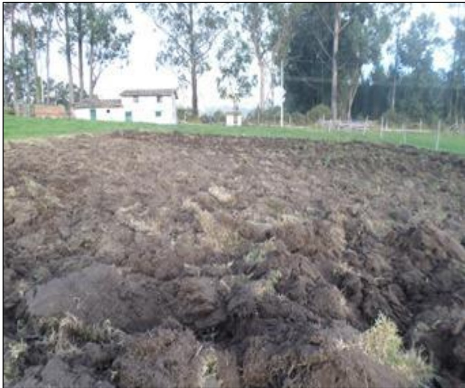
Foto 2. Preparación de terreno.
