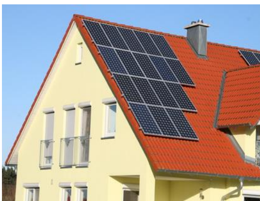
Figura # 30: Instalacion de los paneles solares. http://www.isolari.es/wp-content/uploads/2012/07/instalacion-placas-solares11.jpg
