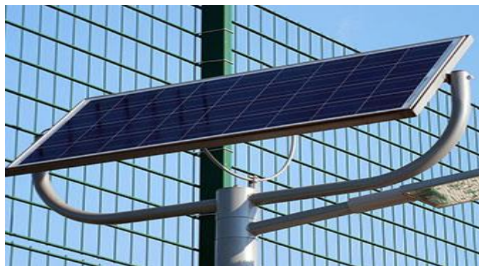
Figura # 31: Instalación fotovoltaica y la colocación de los paneles solares https://encrypted-tbn0.gstatic.com/images?q=tbn:ANd9GcRUwYILWcZr
