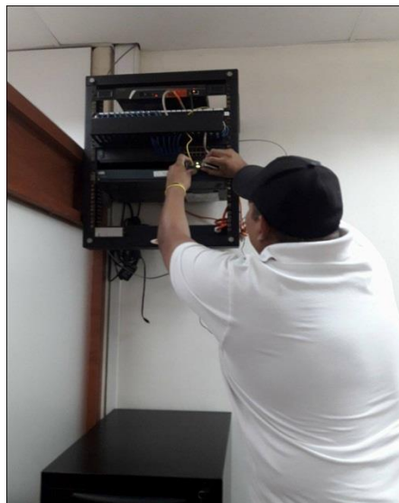
Revisión de conexiones de cables utp al Switch.
