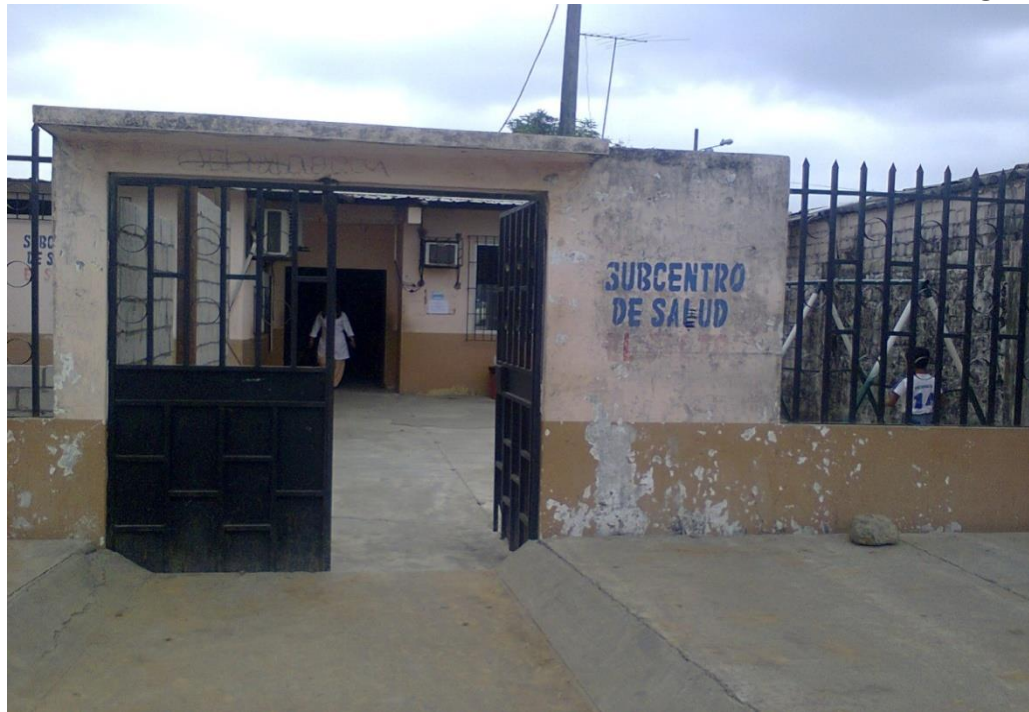
INSTALACIONES DEL SUB CENTRO DE SALUD EL SALTO
