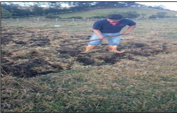
Figura 23. Preparación del terreno.
