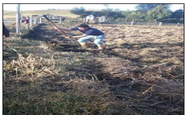
Figura 20. Preparación del terreno.
