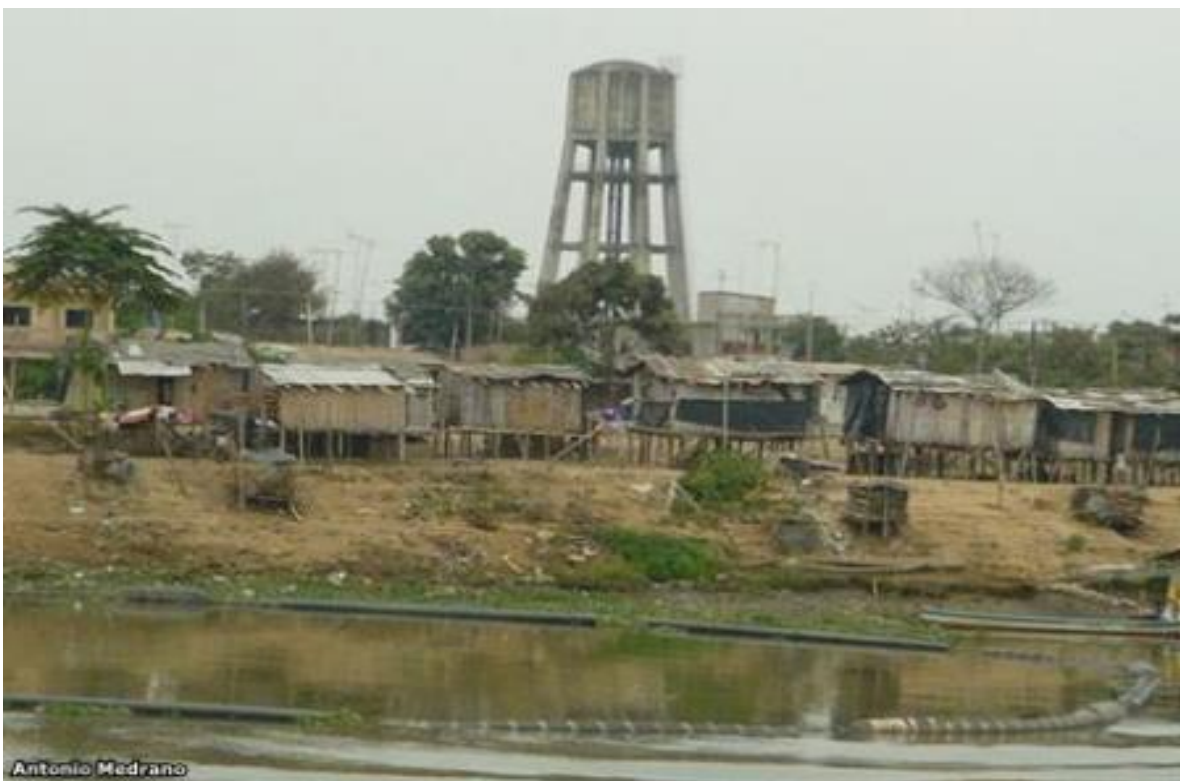
Foto#4.- Vista panorámica de las casas precarias y el tanque elevado de agua potable, de la parroquia El Salto
