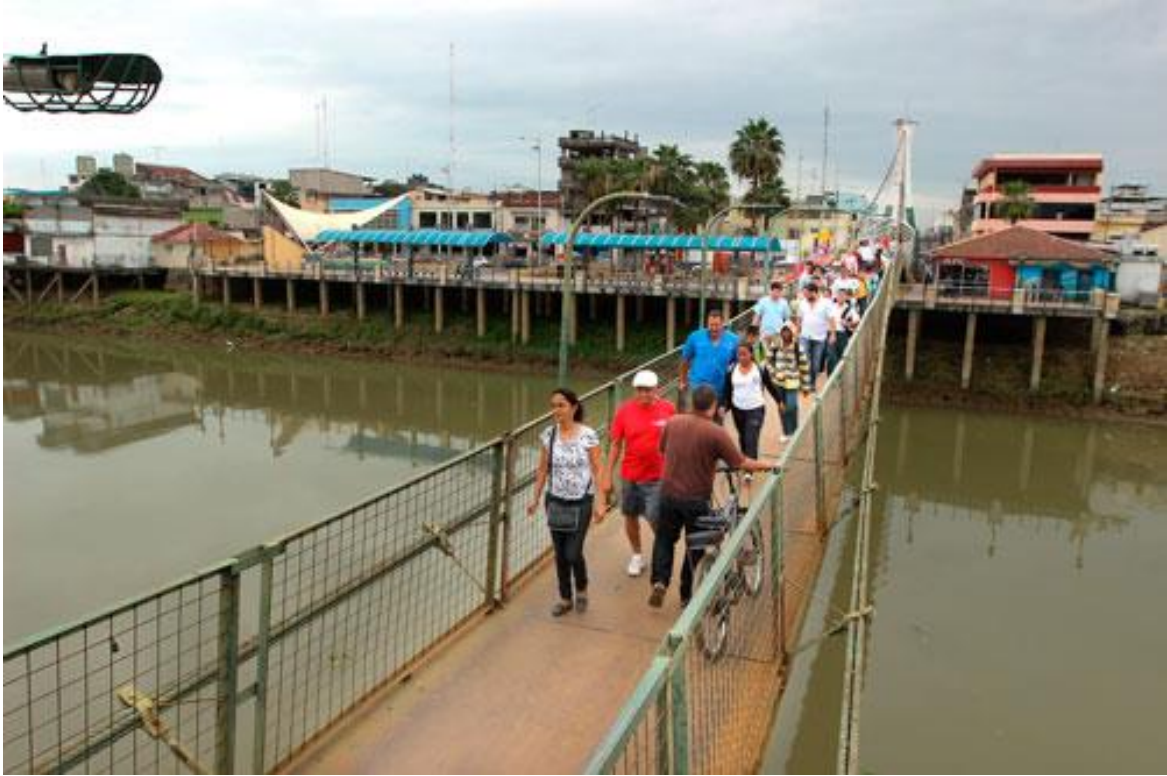
Foto#5.- Moradores de la parroquia El Salto, utilizando el puente peatonal que los une con la ciudad de Babahoyo.
