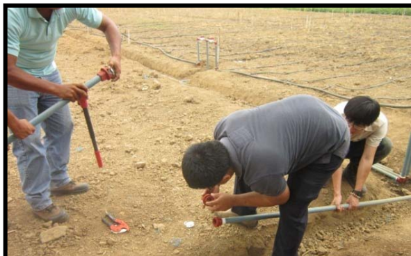
Fig. 5. Instalación de riego por goteo
