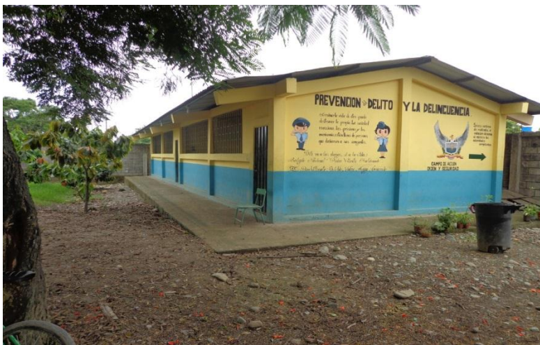
Foto N°6: Pabellón de aulas del Colegio Pedro Vicente Maldonado.
