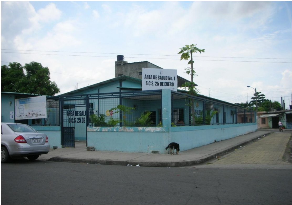
FOTO N° 5 Instalación del Subcentro de Salud
