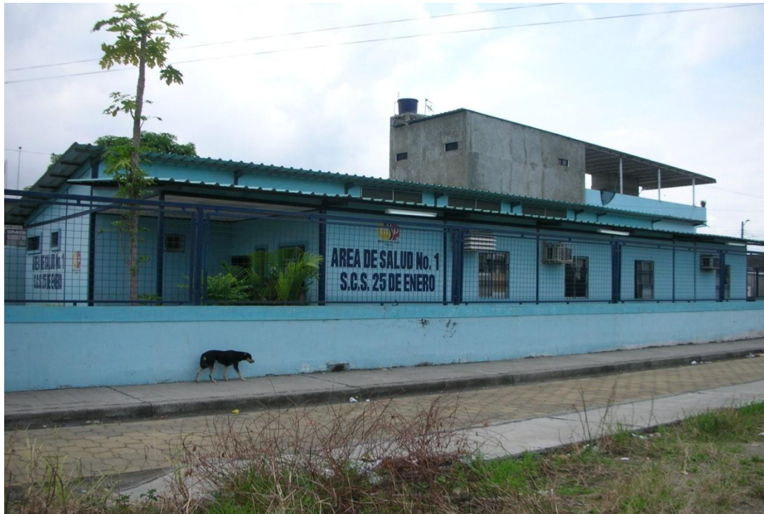
FOTO N° 6 Instalación del Subcentro de Salud
