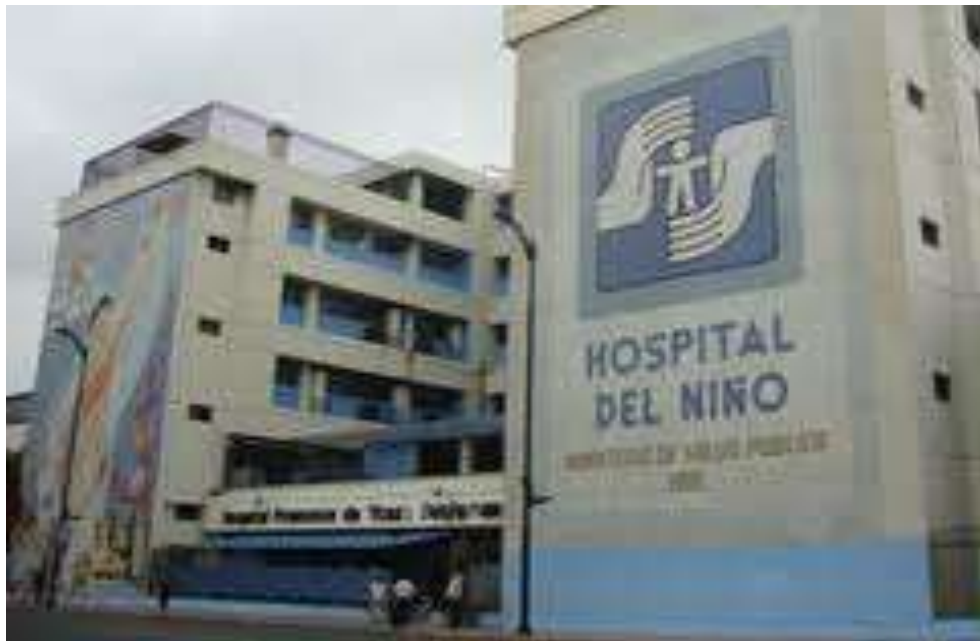
FOTO Nº 1 HOSPITAL FRANCISCO DE YCAZA BUSTAMANTE ANTES DE LA REMODELACIÓN
