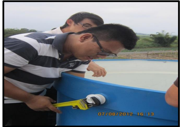
Fig. 2. Instalación del sistema de riego.
