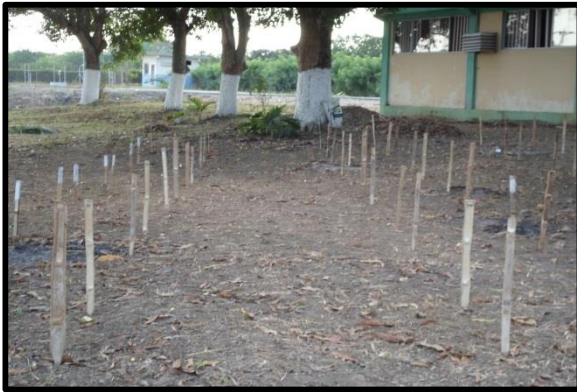
Fig. 3. Preparación del terreno
