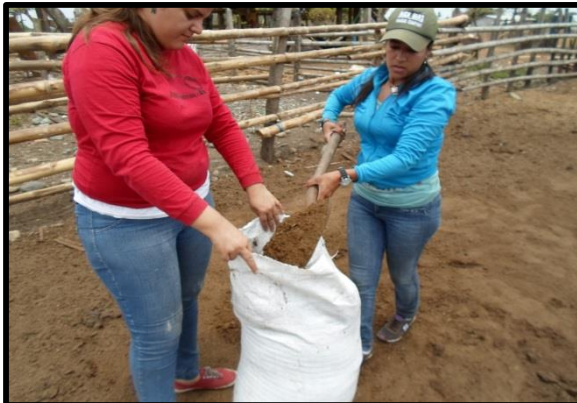
Fig. 5. Colocación de materiales en sacas para elaboración de pilas.
