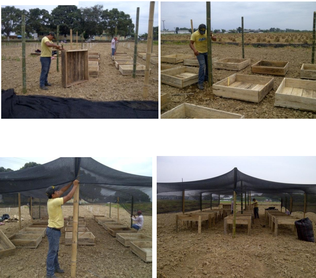
Fig. 2 Construcción del vivero y ubicación de los contenedores
