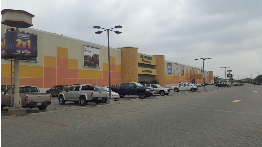
Figura 1. Fachada del Centro Comercial El Paseo Shopping Babahoyo.
