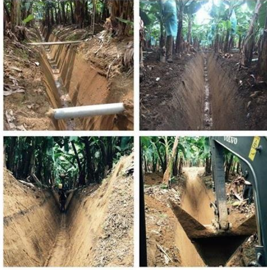
Figura 2. Limpieza De Canales Secundarios Y Terciarios
