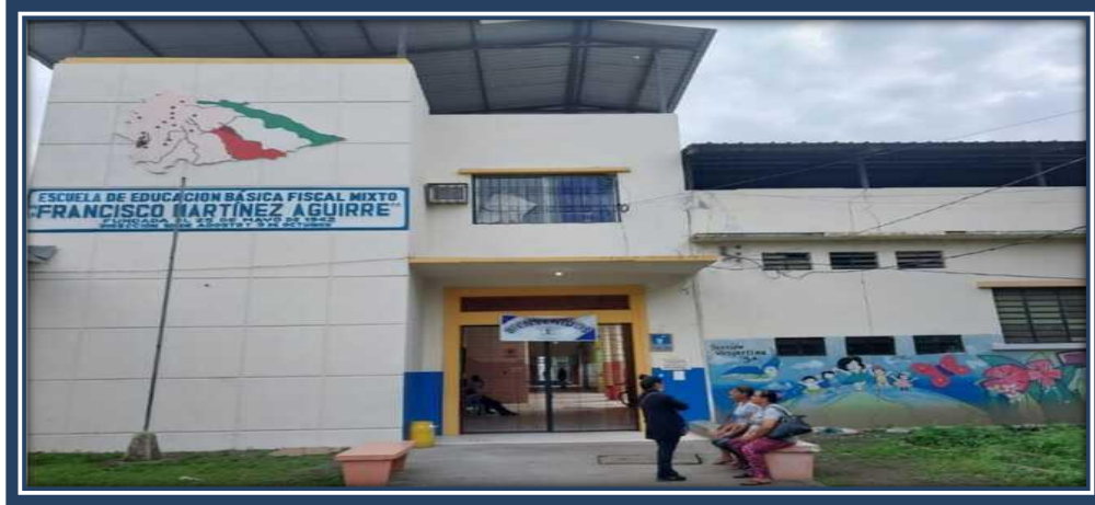
Imagen 1. Edificio Unidad Educativa
