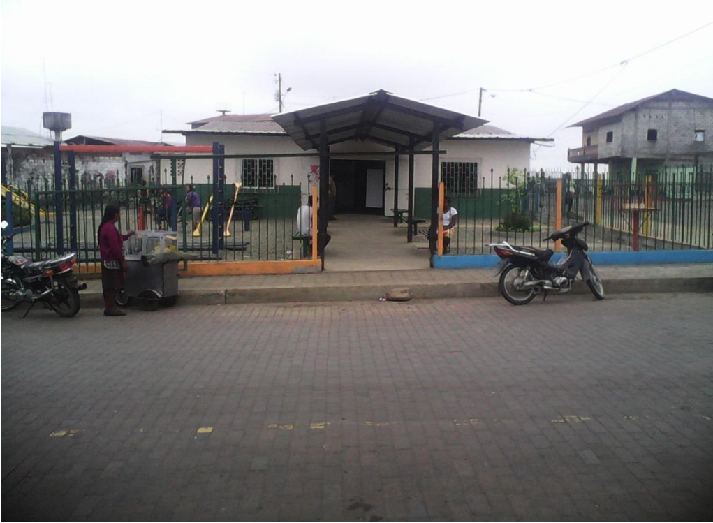
Fachada externa del Centro de Salud
