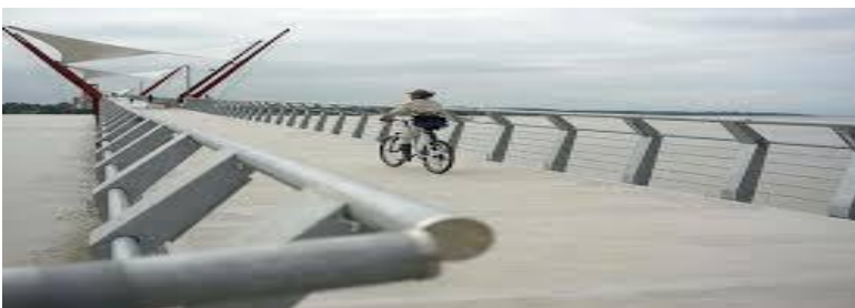
Figura 3. Puente de conexión con la ciudad
