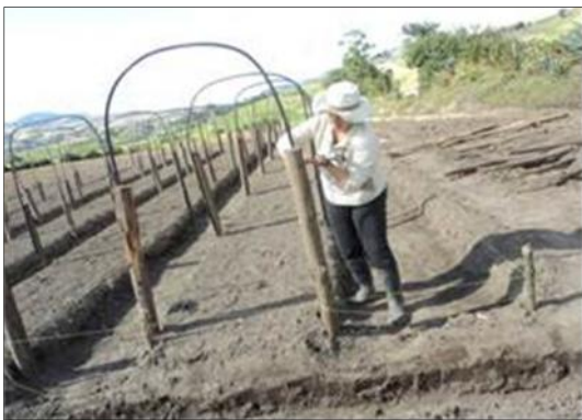
Figura 9. Instalación de micro túneles.
