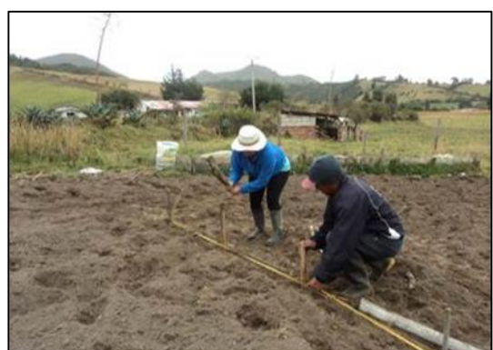
Figura 6. Nivelación del suelo
