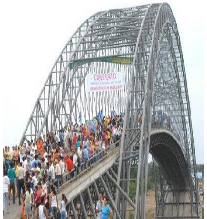
Ilustración 3. Puente Vehicular sobre el Rio Daule
